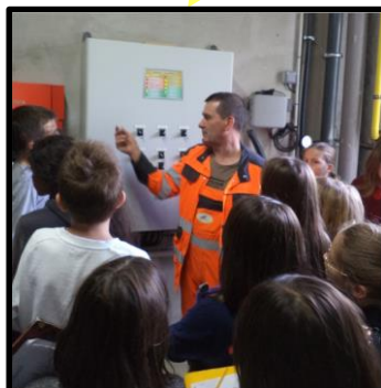
Visite de la chaufferie
